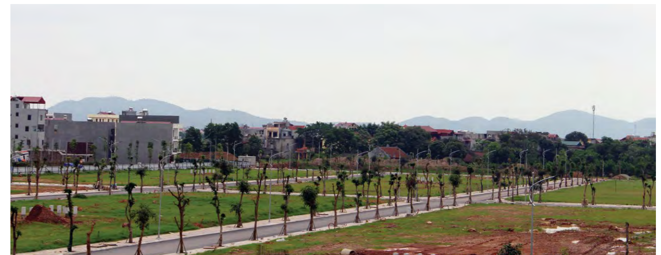
KĐT Phúc Ninh đang hoàn thiện hạ tầng trong tiểu khu 22ha
