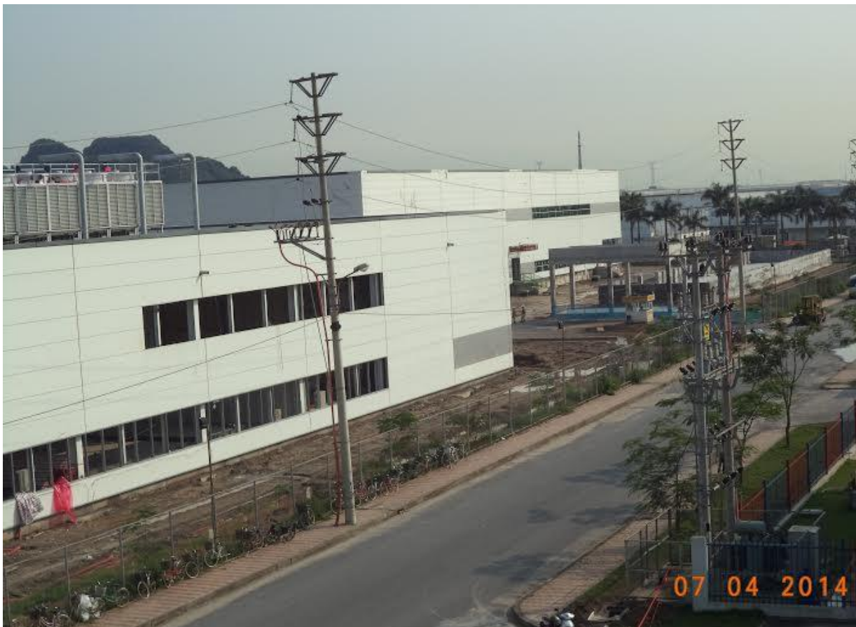
Nhà máy LG đang xây dựng tại KCN Trảng Duyệt - Hải Phòng
