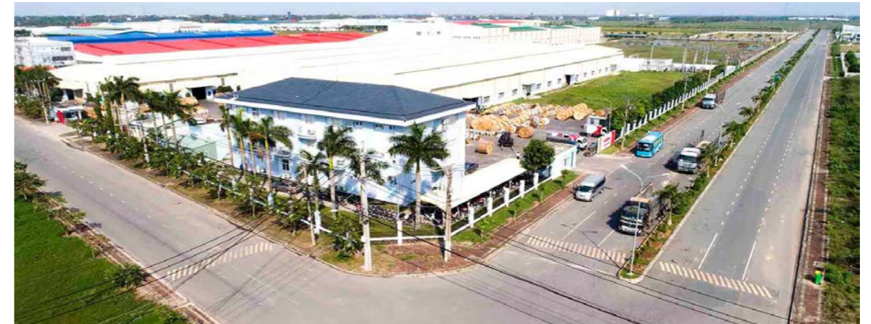
KCN Tân Phú Trung với hạ tầng hoàn thiện
