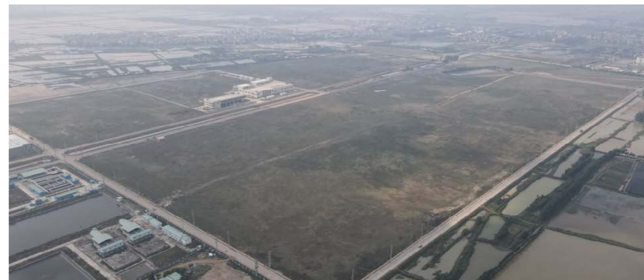
Hạ tầng KCN Nam Sơn Hạp Lĩnh đang hoàn thiện
